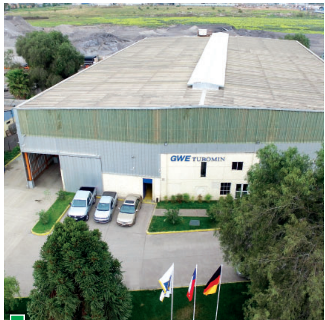
GWE Tubomin Chile, Stahl- und PVC-Fertigung
