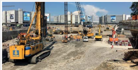
Geothermische Aktivierung von über 700 Gründungspfählen
