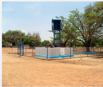
Krankenhaus, Burkina Faso
