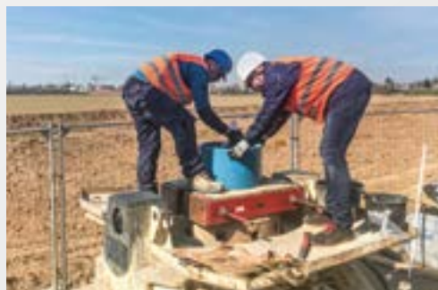
Abfangen unterhalb der Muffe
